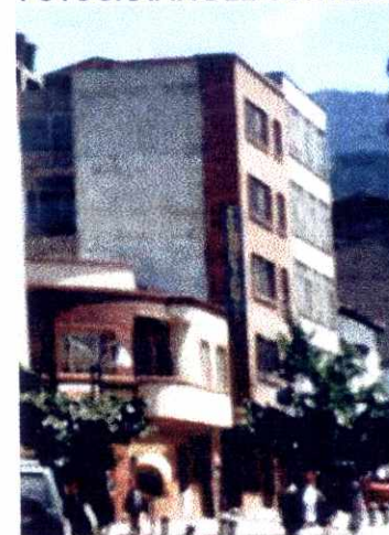
ALTERACIONES A LA EDIFICACION ORIGINAL VISIBLES DESDE EL EXTERIOR :
